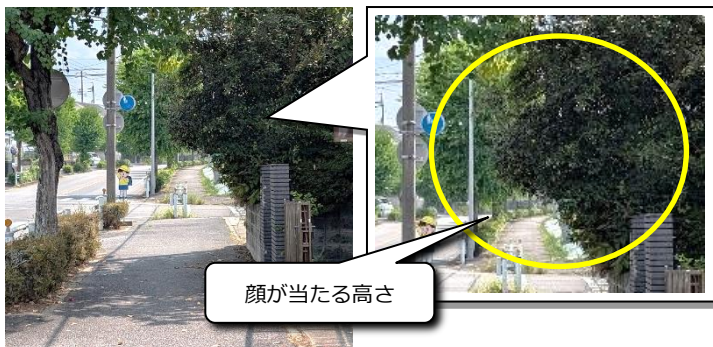
五ヶ丘団地内の通学路において、 空き家から樹木の枝がはみ出して おり、 登下校時の 小学生の顔などに接触 する恐れがある。
