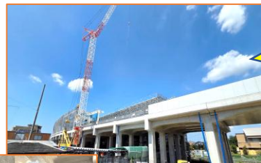
工事現場を視察！
