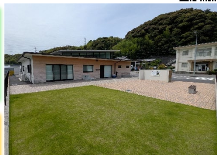
防災機能充実の「やまびこ館」
