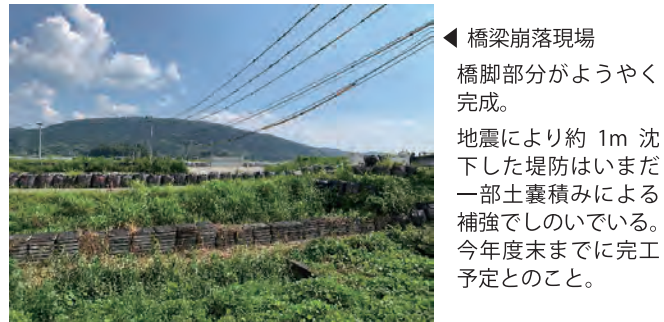
▲橋梁崩落現場
