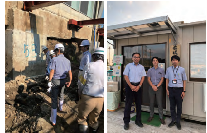
▲公共施設 基礎損壊状況を視察 ▲いまだ仮設の社会福祉協議会
