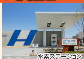
水素ステーション
