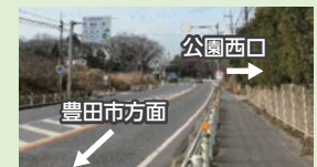
■ 公園西口交差点付近(田柵名古屋線)
