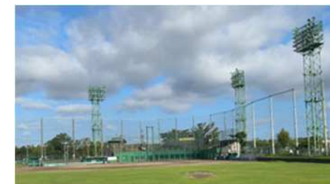
【三好公園 野球場照明塔】
