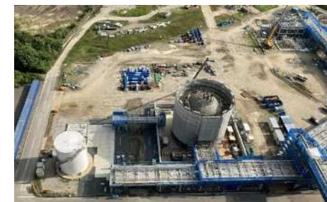
《アンモニアタンクを造成中》 (2023/8/18撮影)
