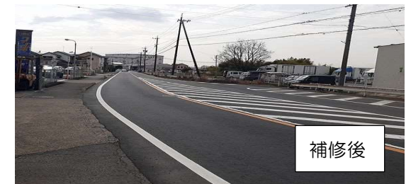
全面補修が実施された当該町道
