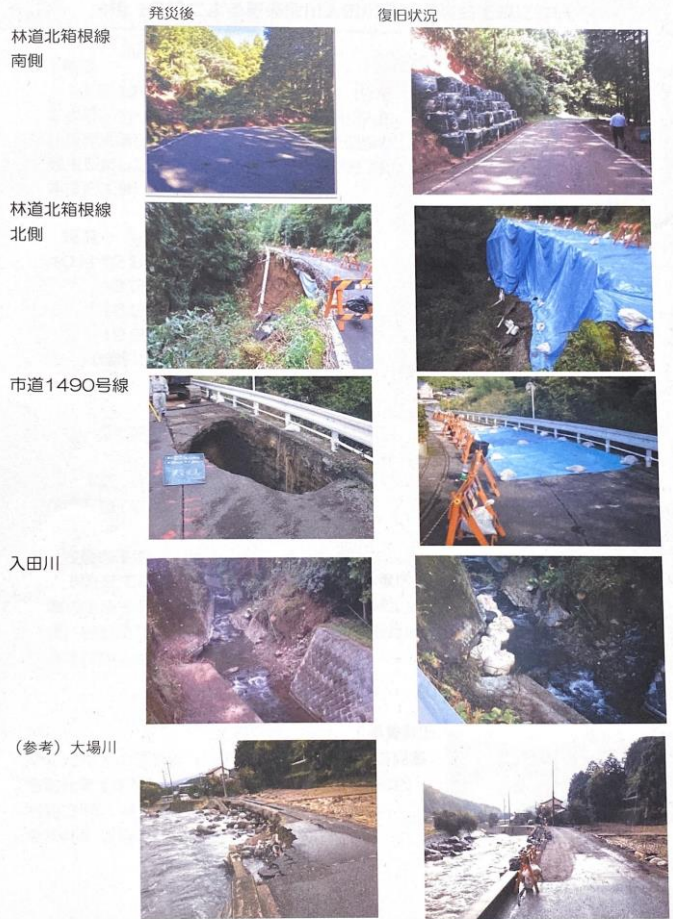
主な災害現場の写真
