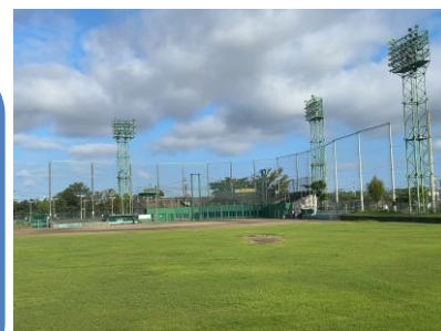
三好公園野球場照明塔
