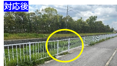
侵入防止柵を設置しました。
