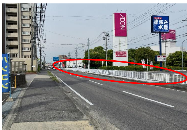
フェンスの施工完了
