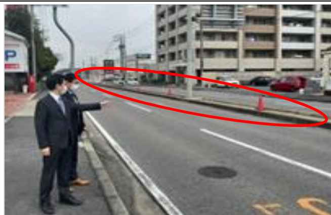
小山県議と施工状況の確認 (植栽撤去)
