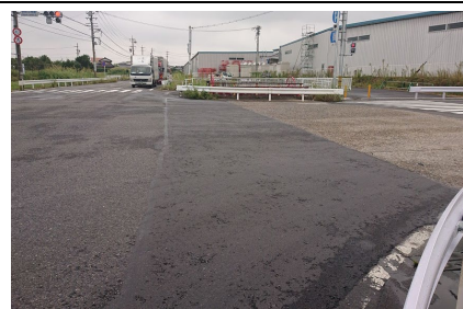
アスファルトにて段差修繕
