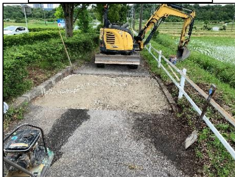
② 6月5日工事現地確認
