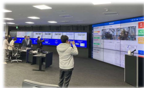
町内にあるシステム管制施設
