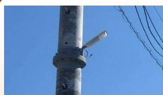
防犯灯の設置（西山町）
