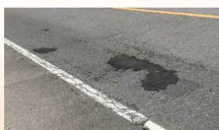
道路の穴あき補修（港南）
