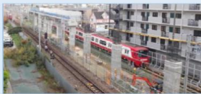
線間施工部の様子(H30.12月撮影)
