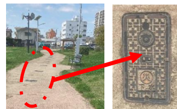
☆大手公園のマンホールトイレ
