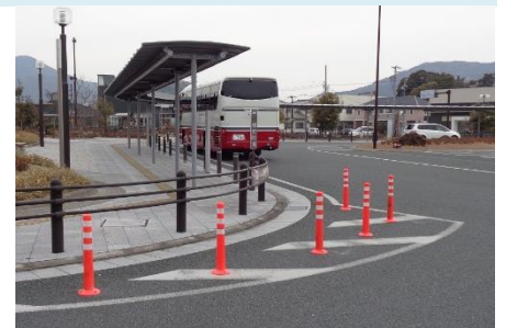
【 安全対策のため、設置されたポールコーン 】
