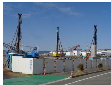
【 バイオマス発電所建設工事 】
