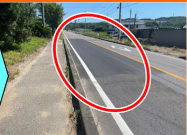
吉良町友国地内の県道317号線にて、道路の轍により、雨天時に車道側から歩行者に雨水が飛散する。
