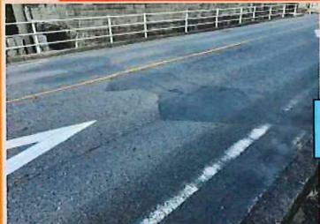
西幡豆町荒佐分地内の県道247号線にて、家屋の振動防止の観点から、道路の段差解消の要望あり。
